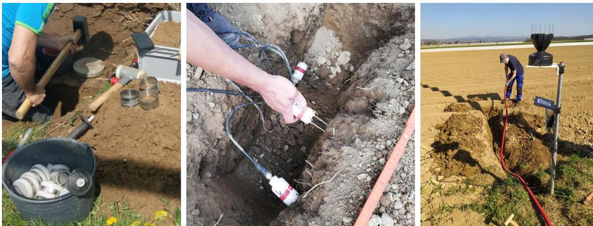
**Slika 2.7: Delo na terenu za vzpostavitev sistema SPON. Odvzem vzorcev, vgradnja merilnikov vsebnosti vode v tleh in povezava merilnikov z komunikacijsko napravo.**
