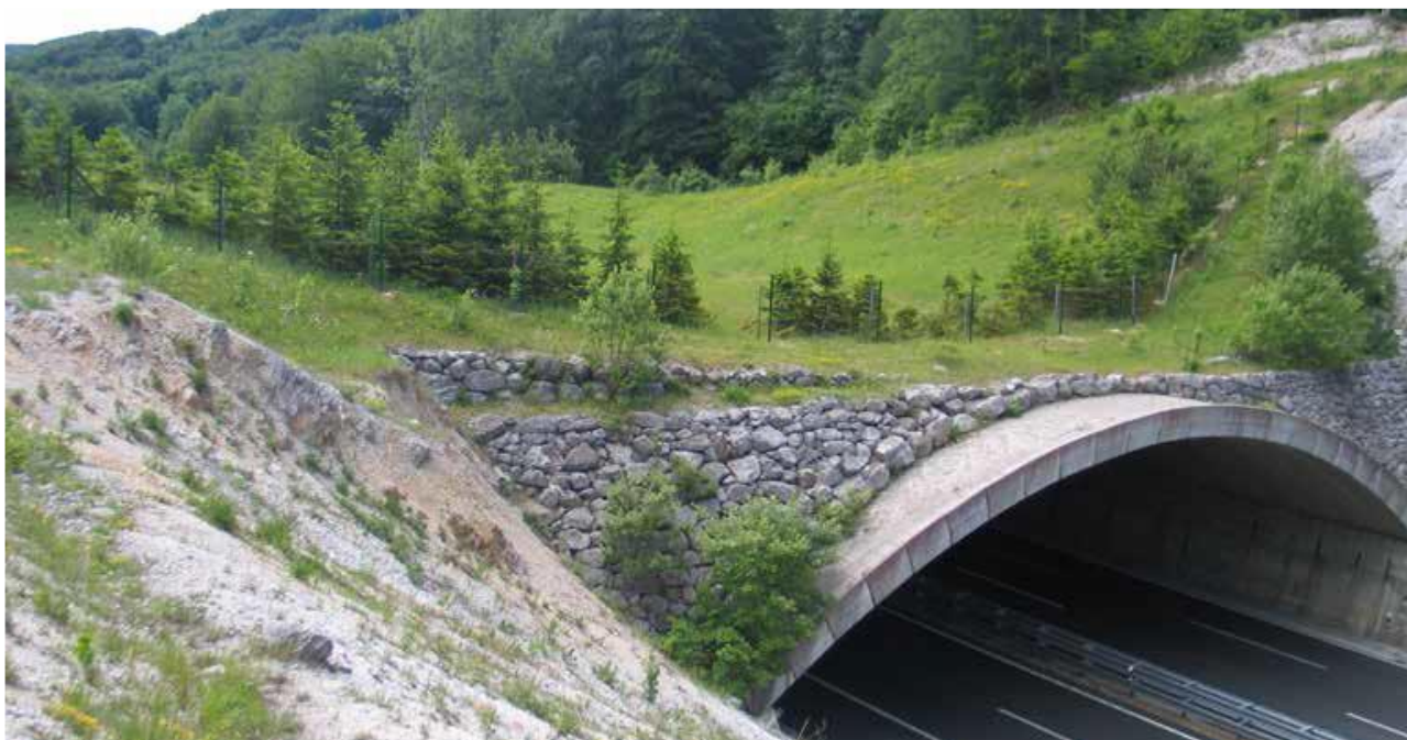
Slika 8: Ustrezno umeščeni zeleni mostovi so med najučinkovitejšimi premostitvenimi objekti za zmanjševanje fragmentacije prostora velikih sesalcev, zlasti velikih zveri. (foto: Huber Đ.; Potočnik 2019)
