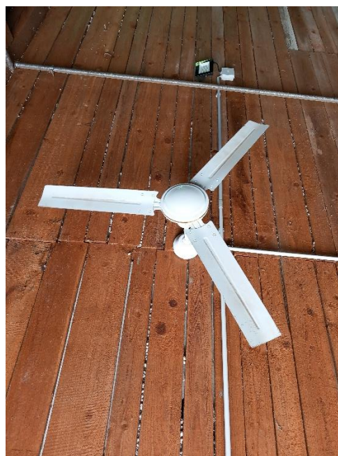
Slika 34: Ventilator na stropu hleva.
