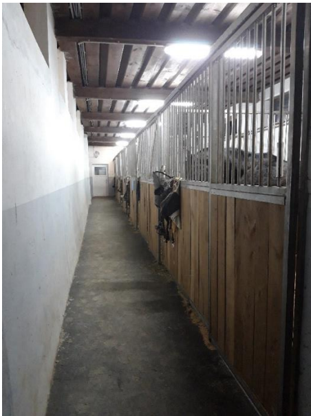
Slika 6: Enovrstni hlev, preozek hodnik; po tleh je položena guma.
