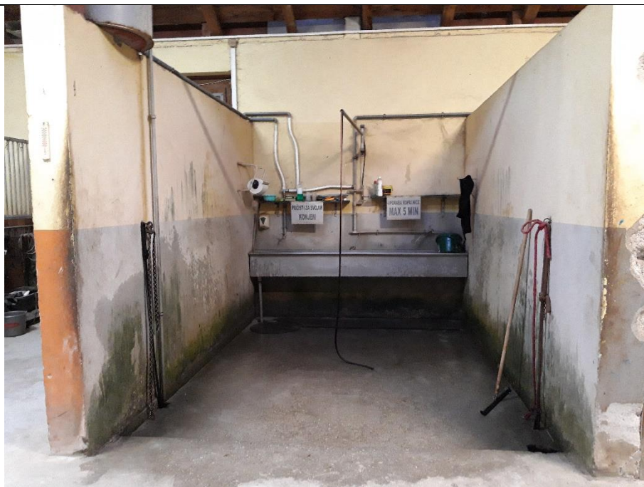
Slika 44: Prostorna kopalnica za konje z betonsko podlago.
