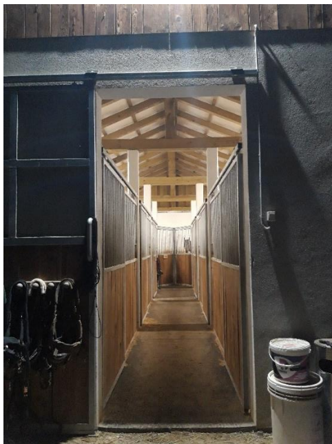
Slika 8: Dvovrstni hlev, preozek hodnik; po tleh je položena guma.
