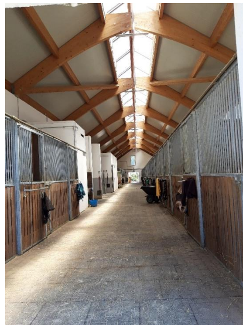
Slika 9: Dvovrstni hlev, omogočeno nemoteno srečevanje in obračanje konj; po tleh je položena guma.
