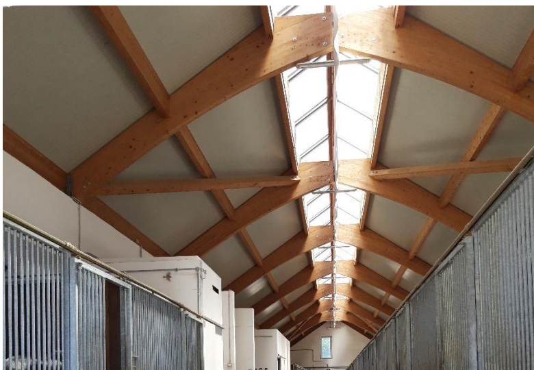
Slika 36: Svetlobni jašek na stropu hleva.
