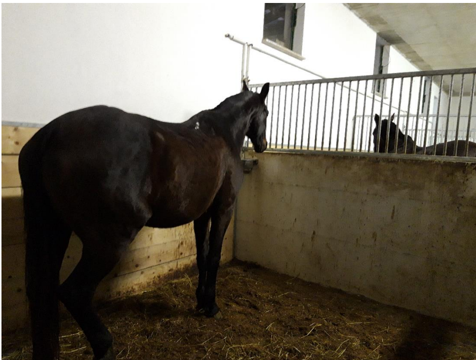
Slika 12: Primer predelne stene, kjer je spodnji del betonski, zgoraj je navpična kovinska konstrukcija; na zunanjih betonskih stenah je lesena obloga.
