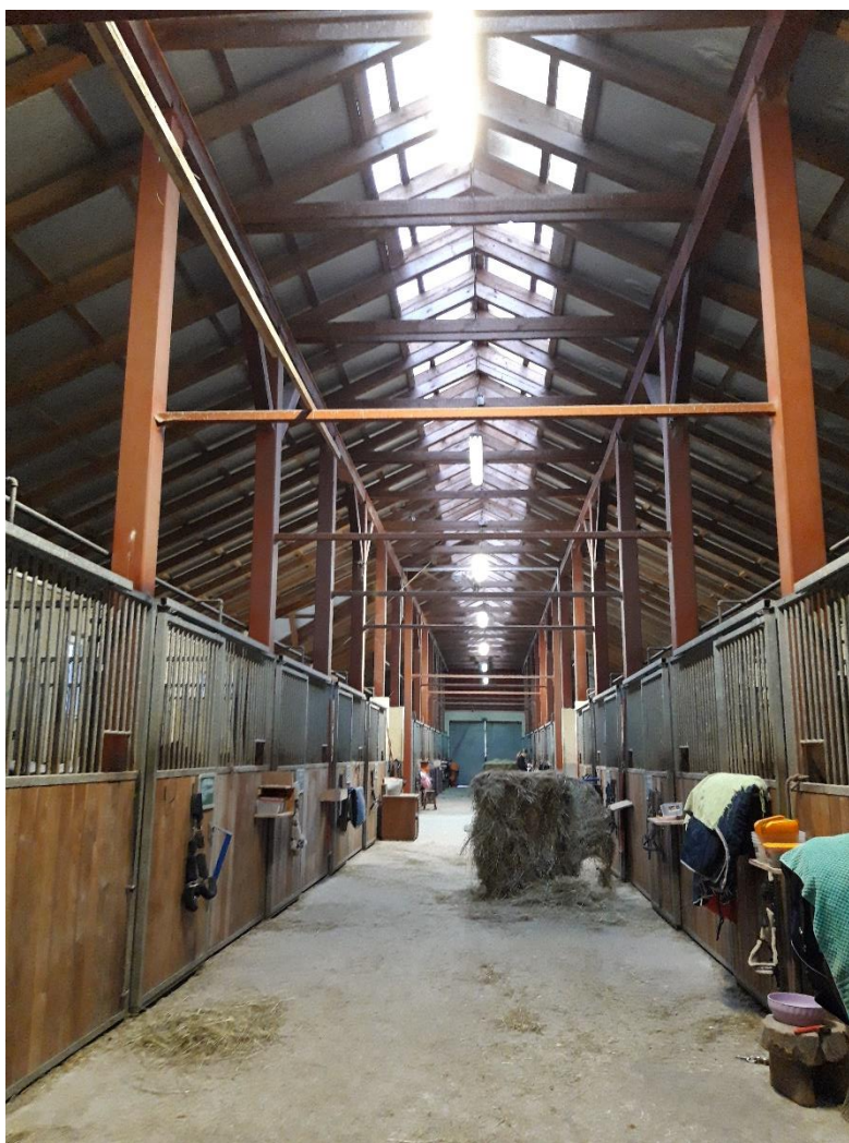
Slika 5: Primer visokega stropa v hlevu.
